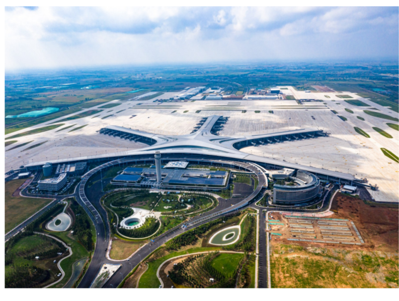
7月1日,由中建八局四公司承建的青岛胶东国际机场项目全面竣工,即将进入转场试飞阶段。该项目为山东省内首个建成的4E级机场,建成后将成为东北亚区域枢纽,形成集航空、铁路、公路、城市轨道交通于一体的综合交通枢纽和全领域、多业态的航空产业链。(四轩)
