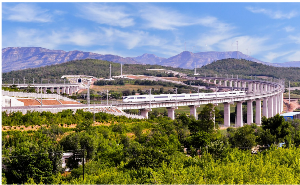
6月30日,一列列车自赤峰站启程开往喀左站。赤峰客专项目全线正式开通运营,其中一段由中建集团承建。自此,作为“八纵八横”高铁网中京哈高铁的重要组成部分,赤峰客专项目将内蒙古自治区赤峰市接入东北大地,成为枢纽联络线。(崔明瑞、王雪莹、季楚)
