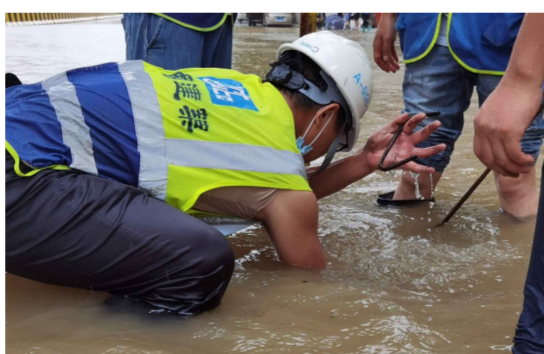
近日,中建三局湖北葛店新城项目组织青年员工,在工地周边开挖排水沟,对积水严重处下水管道进行疏通、清理,协助交管部门维持交通秩序。(郭磊)
