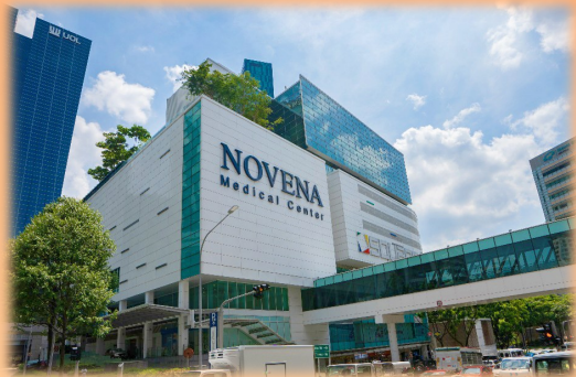
诺维娜医疗中心项目
