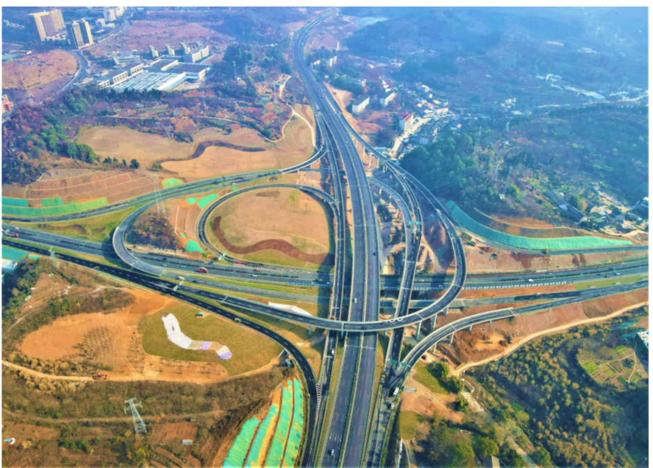
近日，中建三局承建的湖北省宜昌市三峡大道互通立交-港窑路节点互通工程正式通车。项目是宜昌市主城区当前工程体量最大、匝道层数最多、施工难度最高、地理环境最复杂的全互通立交，匝道及集散车道全长5.25公里，设计为“单环式梨形”全互通形式，是宜昌市快速路网“东进、北拓、中优”的重要转换枢纽。(高宏建)
