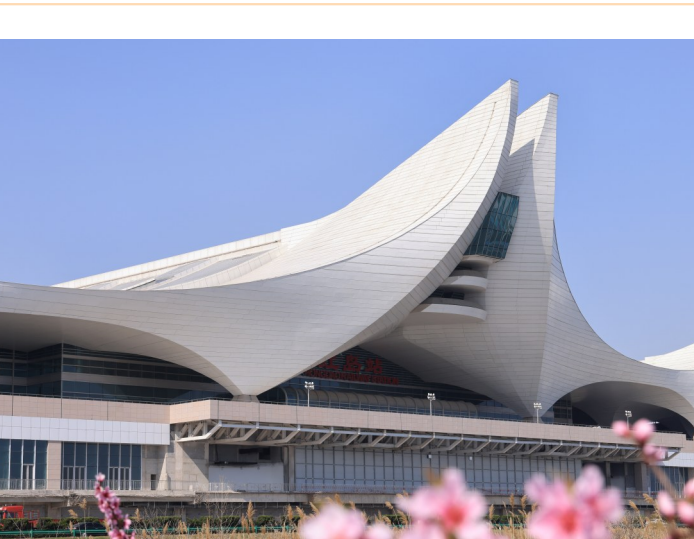
由中建八局承建、中建安装参建的全国首个海景高铁站房——济青高铁红岛站正式办理客运业务,标志着红岛站正式启用。济青高铁红岛站位于青岛市城阳区,是山东省第二大、青岛市最大的高铁站。红岛站开通后,将实现2小时覆盖山东全省、3小时到达京沪的交通网络体系,为国家级特等高铁车站。(王立军)
