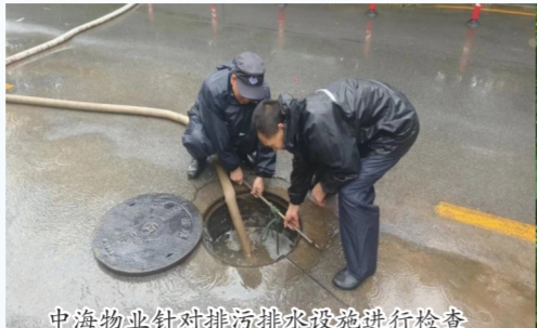
中海物业针对排污排水设施进行检查
