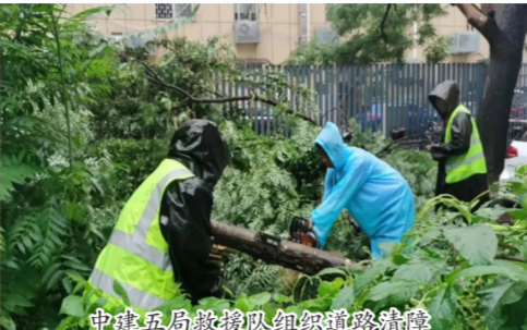
中建五局救援队组筑路路障
