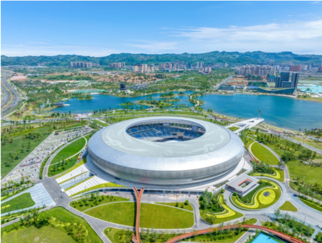
东安湖体育公园体育场是大运会场馆的主场馆及开幕式场地。走进场内，作为成都“标志”的“太阳神鸟”纹饰图案被放大了近270万倍，“安家”在透光屋顶之上。“太阳神鸟”图案由12540块玻璃拼装组成，宽约46米，总面积约27万平方米。这也是截至目前世界面积最大的“太阳神鸟”拼装。
