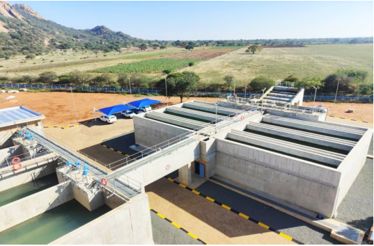
▲博茨瓦纳马哈拉佩水厂项目位于博茨瓦纳首都哈博罗内以北200公里的马哈拉佩镇,建成后,水厂供水能力从原先的每天16兆升提高至34兆升,有效提高了水厂供水能力,缓解了当地居民用水难的问题,并改善当地居民的用水质量。
