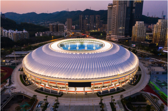
▲场馆泛光照明
