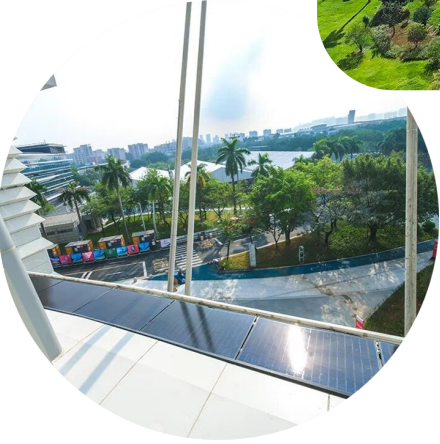
◀场馆光伏设施无处不在
